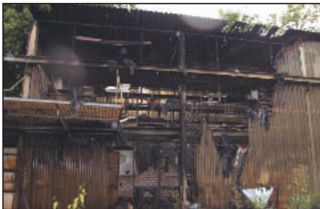
Brand des leerstehenden Lager- und Geschäftsgebäudes Schäfer am Bahnhof, direkt neben den Gleisen. Fotos: Löschzug Stadtmitte
