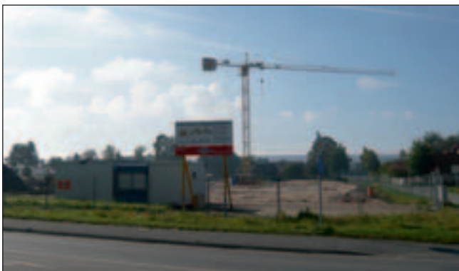
Deutliches Zeichen vom Baubeginn: Das Bauschild und der Kran der Fa. Ostendorf. Foto: ust
