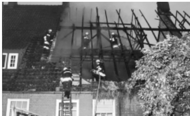
Bei strömendem Regen und mit wenig Mannschaft mussten die Arbeiten erledigt werden. Fotos: Schüttken
