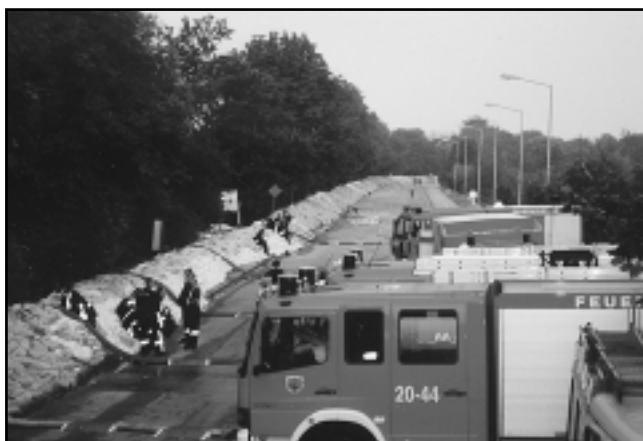
Sandsack auf/neben Sandsack: Nur so konnten die Deiche gesichert und die Wassermassen ferngehalten werden. Foto: Steinigeweg
